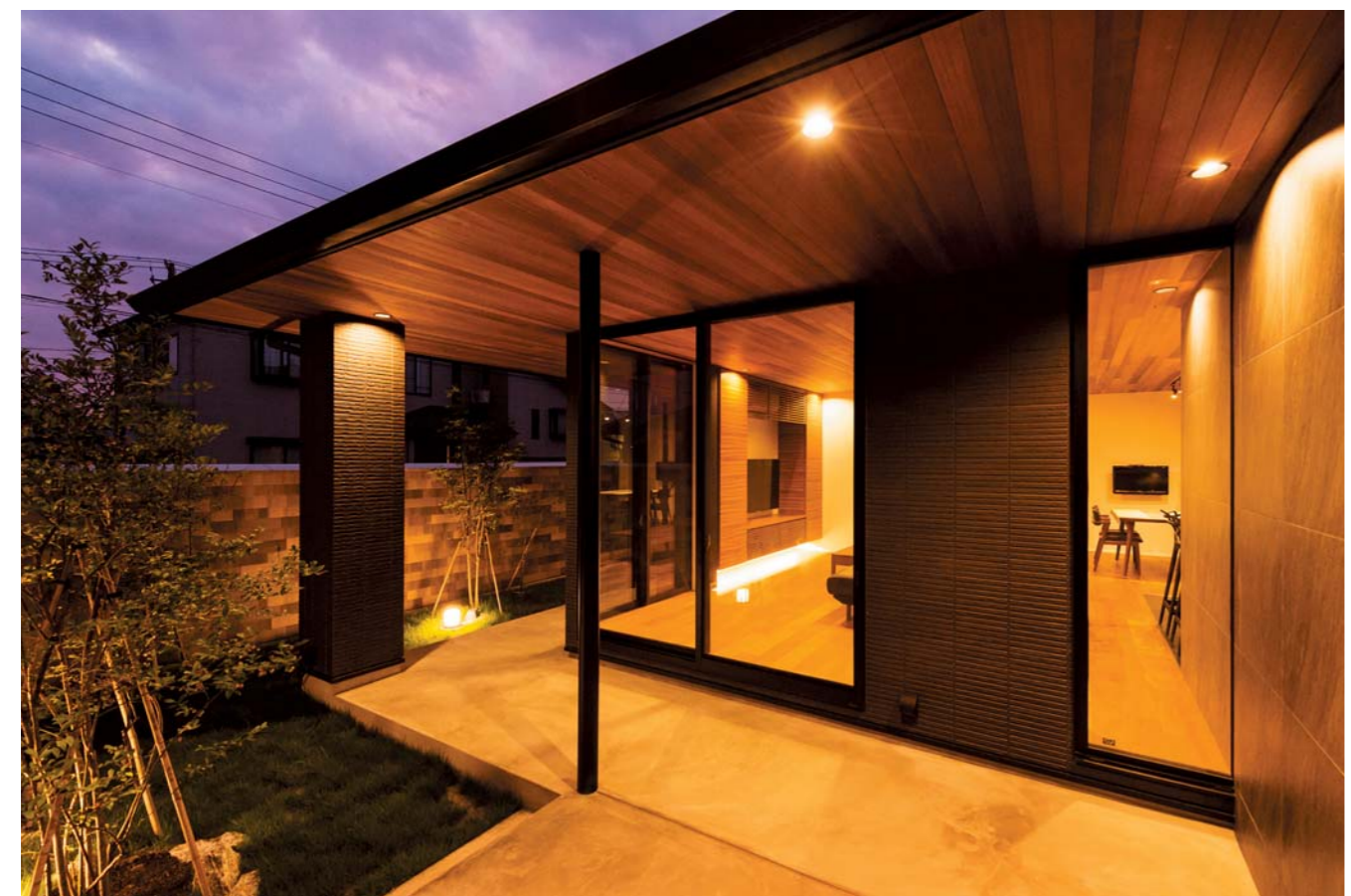
1800mmの深い軒はコンクリートのテラスの上に大きく張り出し、テラスの屋根としても機能。天井に張ったレッドシダーが、室内と屋外を大きくつなげている
