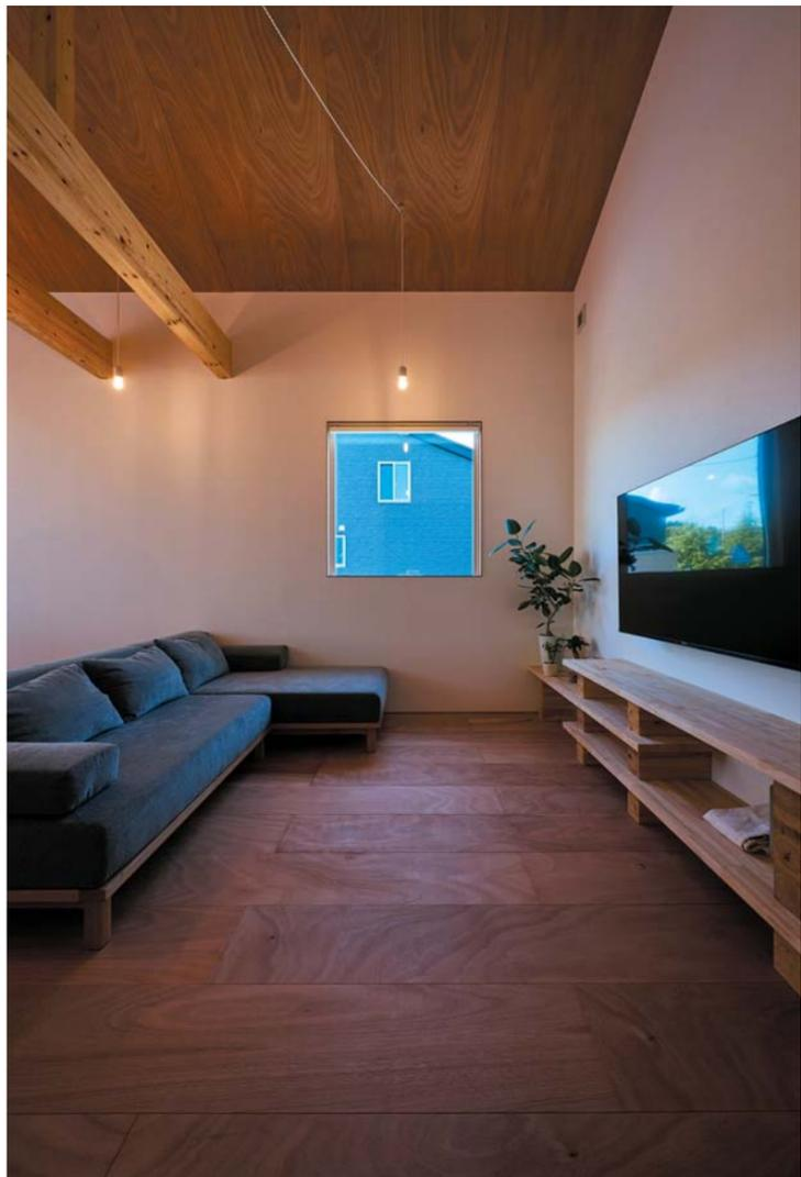
床と天井にラワン合板を採用したリビングスペース。合板をカットして張った床は、新しい「無垢の床」の提案でもある。天井、壁、床の際や合板の突き合わせなどのディテールに、施工の力が光る。窓枠にはすべて、厚さ5mmのラワン合板を採用
